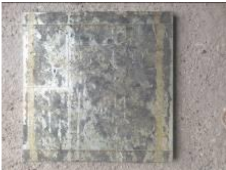
Dalle encapsule après démontage
